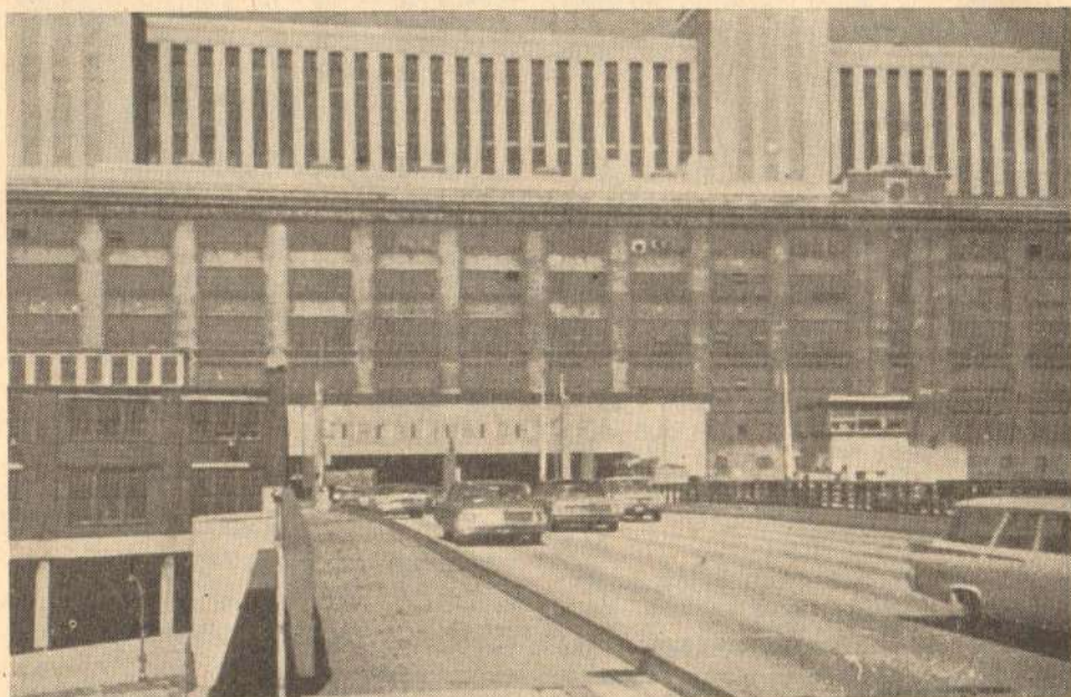
Сл. 2. Аутопут Congress Expressway пролази кроз зграду поште у Chicago-у
