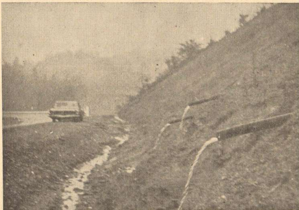
Процењивање шкарпе пута цијевима \phi 2 инча
